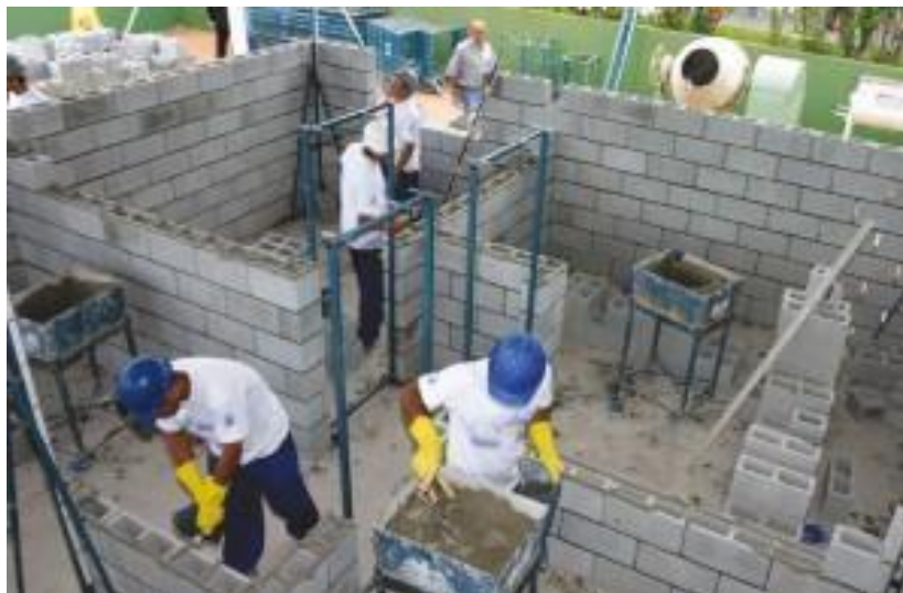
Figura 2: Alvenaria com blocos de concreto na execução de uma edificação
