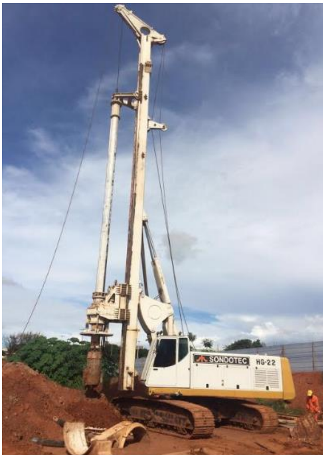
Figura 13: Equipamento de perfuração da estaca escavada com fluido estabilizante.
