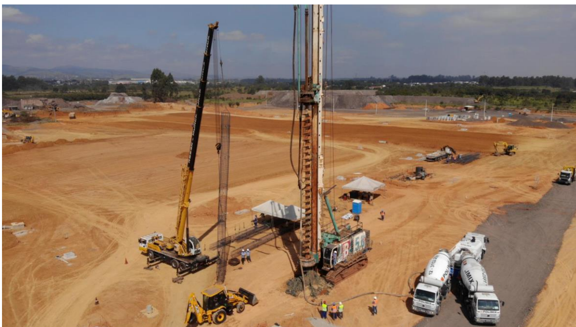
Figura 19: Execução de estaca hélice, final da concretagem e preparo para inserção da armadura
