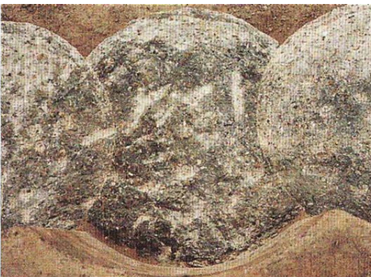
Figura 11: Detalhe da justaposição das estacas secantes
