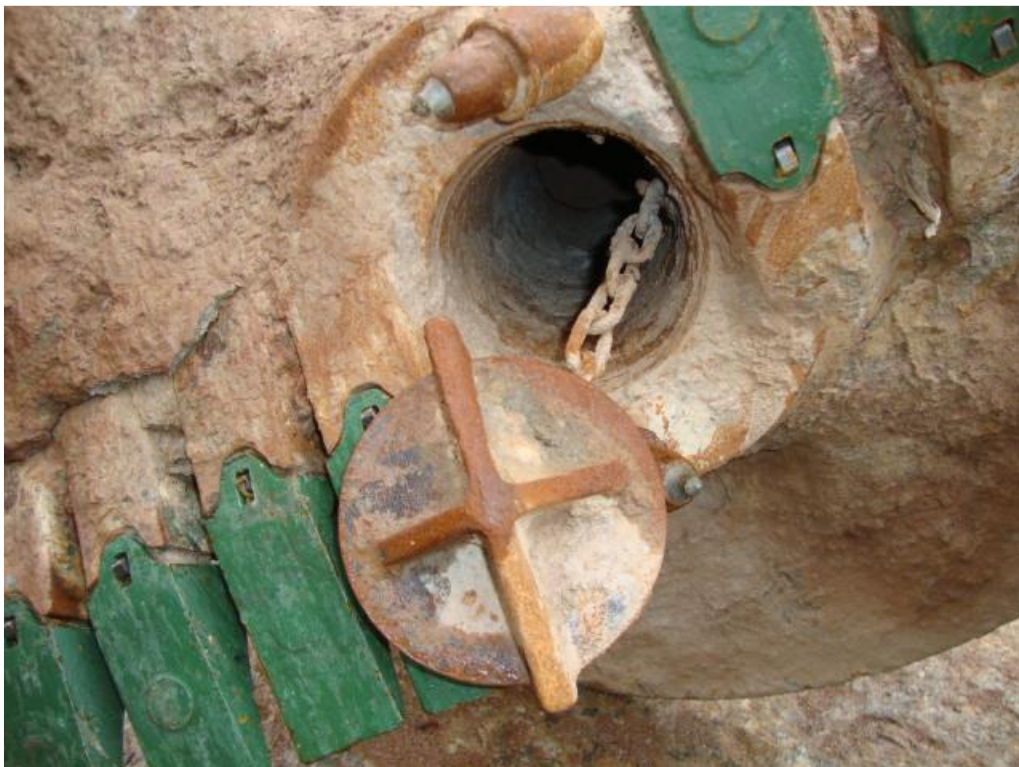
Figura 18: Concretagem – vista da tampa do trado aberta
