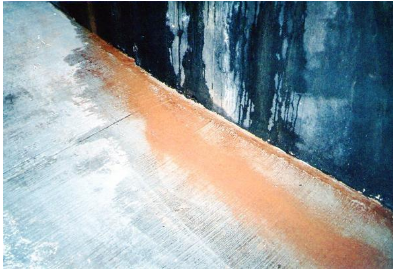
Figura 1: Infiltração em subsolo
