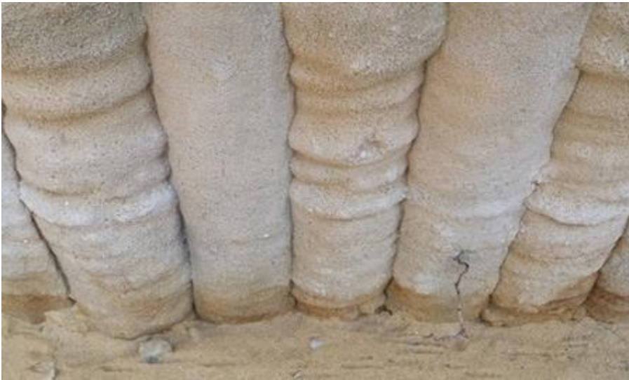
Figura 12: Vista da formação da parede em estacas secantes
