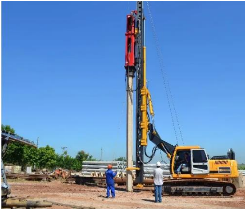
Figura 16: Equipamento bate-estaca em cravação de uma estaca de concreto pré-moldada
