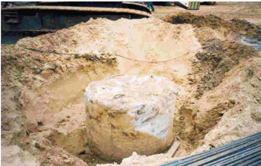
Figura 14: Estação: cabeça da estaca pronta para arrasamento.
