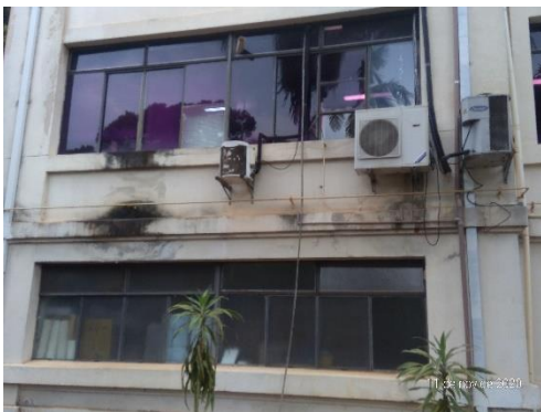
Imagem 9 – Fachada Leste, situação atual das esquadrias e infiltração dada pelos equipamentos de ar-condicionado.
