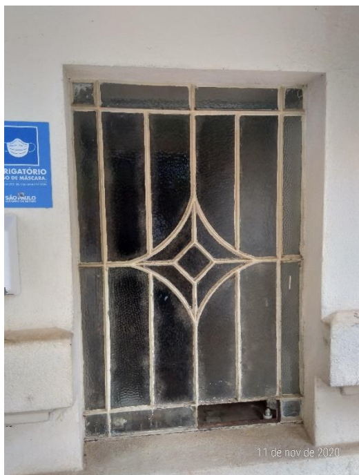
Imagem 43 – Fachada Oeste, detalhe para a atual situação de uma das janelas, se encontrando alguns sem vidro nas esquadrias.
