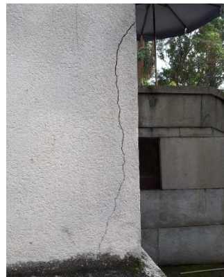
Imagem 4 – Lado esquerdo. Trinca da argamassa, em conjunto com a umidade da parede.
