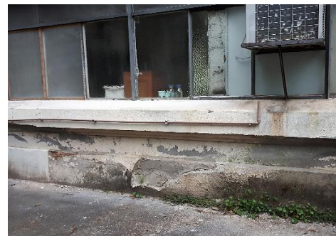
Imagem 32 - Lado esquerdo. Há um grande despreendimento da argamassa com uma tentativa de obstrução, além de crostas negras na base da parede com infestação biológica.
