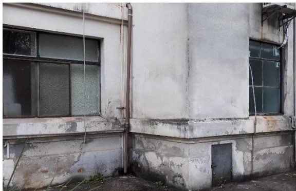
Imagem 3 – Lado esquerdo. Insfestações biológicas nascendo na base da parede em conjunto com a umidade. Ocorrência de crostas negras.
