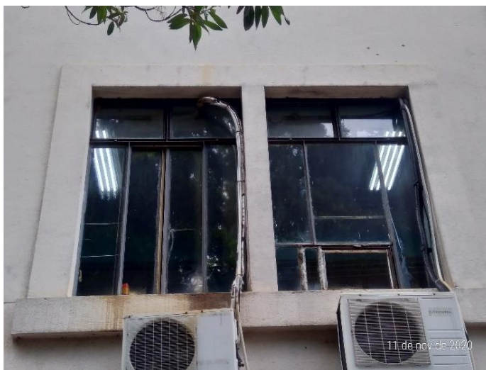
Imagem 53- Fachada Sul, detalhe para a atual situação da janela e de suas esquadrias, que por conta das instalações externas tiveram suas modulações de esquadria modificadas.
