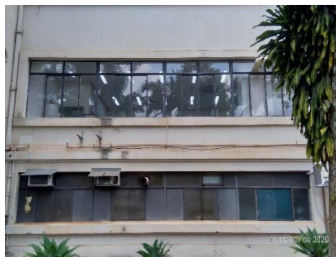
Imagem 10 - Fachada Leste, situação atual das esquadrias e infiltração dada pelos equipamentos de ar-condicionado.
