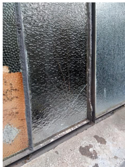
Imagem 36 - Fachada Oeste, detalhe para a atual situação das esquadrias e dos vidros, alguns trincados e danificados.
