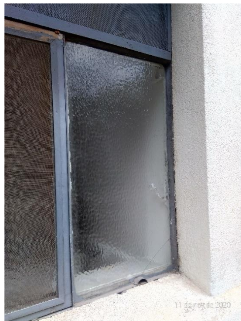
Imagem 38 - Fachada Oeste, detalhe para a atual situação das esquadrias e dos vidros, se encontrando alguns trincados e danificados.
