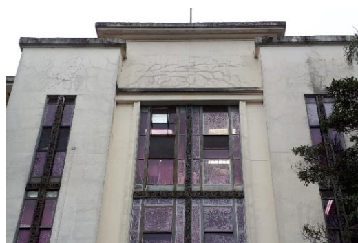
Imagem 6 – Parte frontal. É visto várias frissuras oriundas da umidade no frontão, e as crostas negras presentes em praticamente todos os frisos e beirais.
