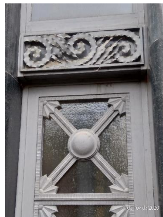
Imagem 16- Fachada Leste, porta da entrada principal, detalhes dos ornamentos metálicos da esquadria da porta metálica, com vidro original.
