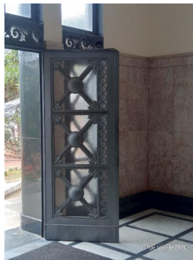
Imagem 12- Fachada Leste, detalhe dos ornamentos da porta metálica, com vidro original.
