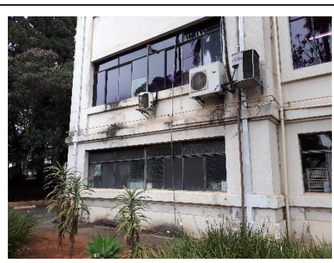
Imagem 2- Lado esquerdo. É visto os acúmulos de sujeiras pela umidade, e a sujeidade provindas das instalações de ar condicionado.
