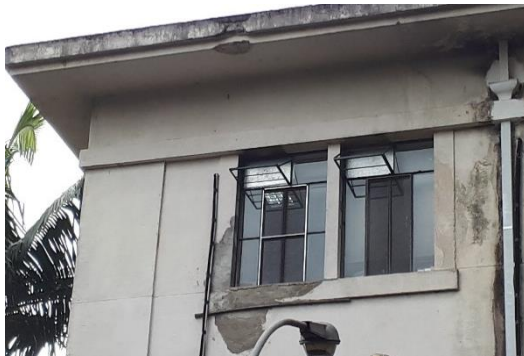
Imagem 19 – Lado esquerdo. Existe uma grande obturação de argamassa ao redor da janela, e um desprendimento da argamassa no beiral, os tubos de águas pluviais também possuem uma grande área de umidade por infiltração fazendo surgir a crosta negra.
