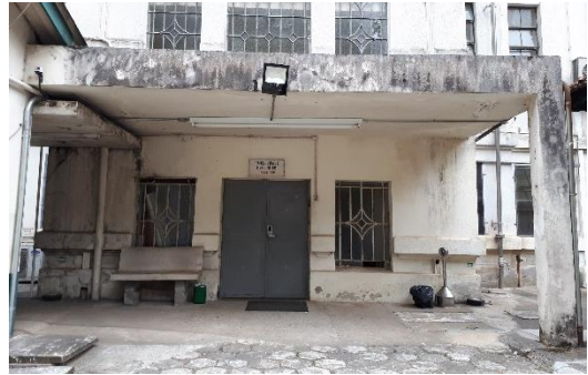
Imagem 30 - Entrada posterior. Essa entrada está com grande problema de umidade e de crosta negra, tendo infestação biológica principalmente nos cantos e junções dos elementos, além da perda da camada pictórica.
