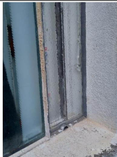
Imagem 22 - Fachada Norte, detalhe da situação atual e da esquadria da janela. Massa de vidraceiro em desprendimento.
