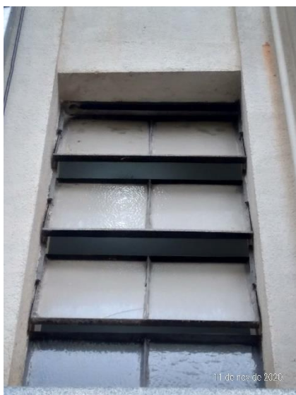
Imagem 39 – Fachada Oeste, detalhe para a atual situação das esquadrias e dos vidros, se encontrando uma gran sujeidade em algumas janelas.
