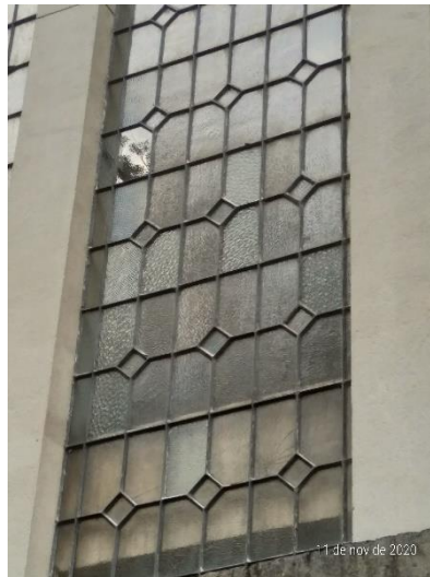
Imagem 46- Fachada Oeste, detalhe para a atual situação da janela principal, encontrando alguns vidros com certa divergencia estética.
