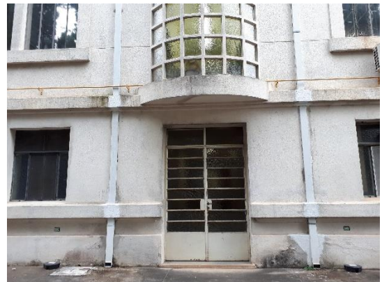
Imagem 48- Entrada lateral. É notada a umidade presente perto dos canos de tubulação e nos beirais das janelas, essa devido ao escoamento da água da chuva, causando crosta negra.
