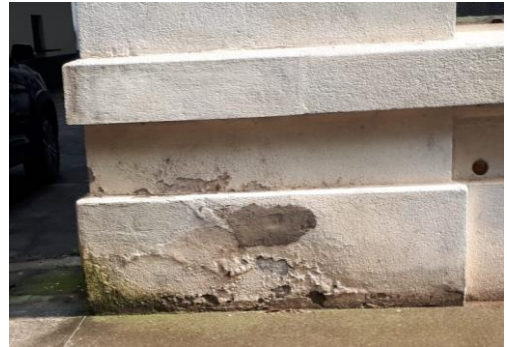
Imagem 50 - Lado esquerdo. É visto a umidade na base da parede gerando o desprendimento da camada pictórica e uma pequena aparição de bolor no canto esquerdo. Essa área possivelmente já sofreu uma perda de argamassa anteriormente, notada pela obturação presente.
