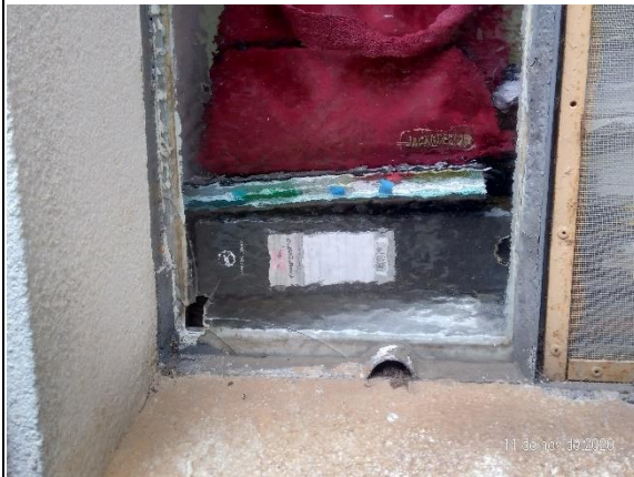
Imagem 21 – Fachada Norte, detalhe da janela com seu vidro danificado. Vidros quebrados, e massa de vidraceiro em desprendimento.
