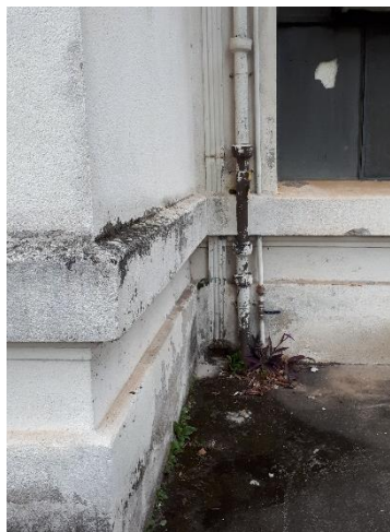
Imagem 7 – Lado esquerdo. Despreendimento da camada pictórica ao longo da parede, e crostas negras presentes principalmente nos frisos e nas áreas adjacentes às instalações hidráulicas.
