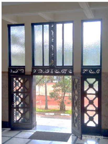
Imagem 11 – Fachada Leste, porta da entrada principal. Porta duas folhas e metálica, com vidro original, com a bandeira seguindo a mesma linguagem.
