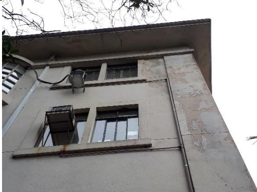
Imagem 49 – Lado direito. Nota-se uma grande massa de umidade que percorre a lateral da fachada causando um grande desprendimento da camada pictórica. É visto uma mancha de ferrugem por oxidação embaixo da janela provinda das instalações.
