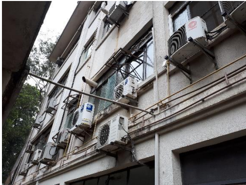
Imagem 29 - Lado esquerdo. Há um grande número de instalações de ar condicionado e outras instalações do gênero que são uma das causas dos problemas das patologias presentes nas paredes das fachadas, tanto pela umidade que eles geram quanto pela ferrugem que os encanamentos soltam.
