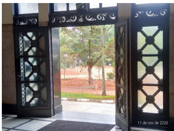
Imagem 13 – Fachada Leste, porta da entrada principal. Porta duas folhas e metálica, com vidro original.
