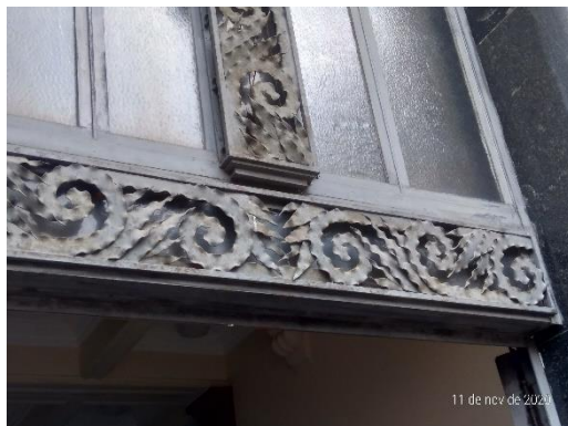
Imagem 15 – Fachada Leste, porta da entrada principal, detalhes dos ornamentos metálicos da esquadria da porta metálica, com vidro original.
