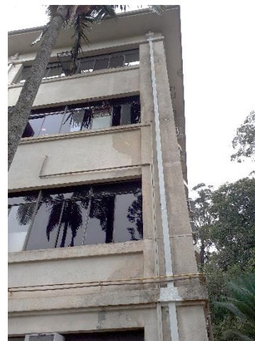
Imagem 8 – Lado esquerdo. É possível ver a obstrução feita para a instalação de tubo hidráulicos, e as instalações secundárias que passam pela fachada, mas o maior destaque é a grande mancha de umidade que ocorre na parede.
