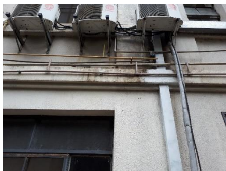
Imagem 31 - Lado esquerda. É notada a obstrução feita para a instalação de dutos de instalações, e a sujeira tanto pela ferrugem da oxidação dos aparelhos de ar condicionados.
