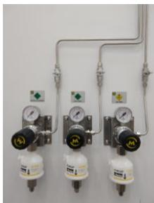
Modelo dos reguladores do posto com serpentina, válvulas de bloqueio, válvulas de purga, válvulas reguladoras com manômetro e válvula de alívio/segurança conforme figuras abaixo.
