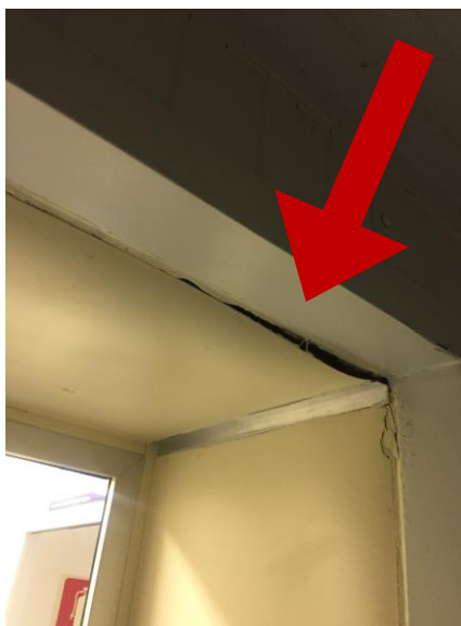
Figura 6 - remover revestimento no acesso a porta do trecho indicado pela seta vermelha.
