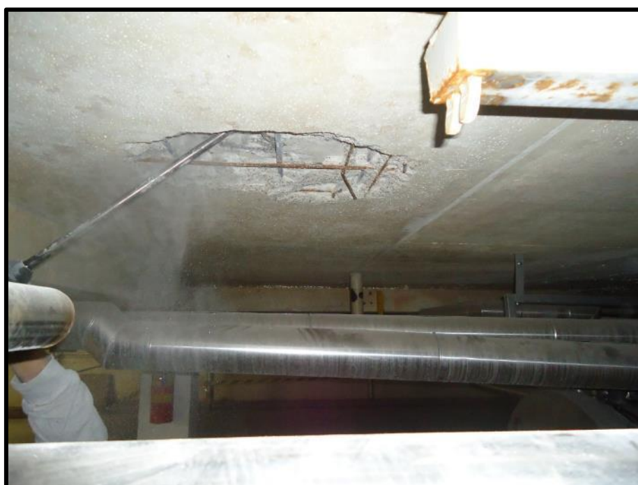
Foto 9 – Prospeção destrutiva em laje para identificação de diâmetros, quantidade e disposição de armaduras.
