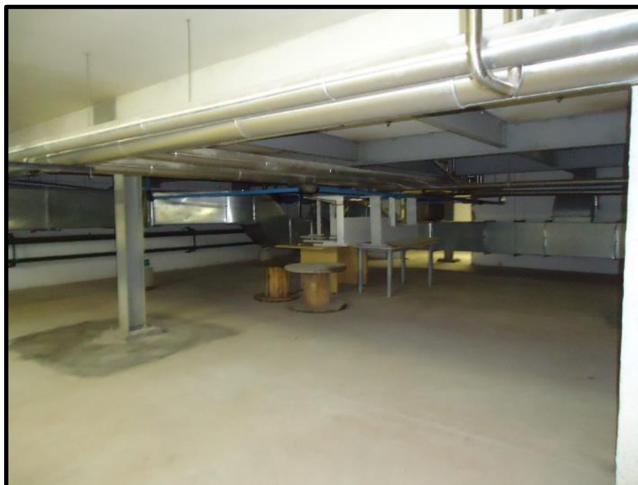
Foto 26 – Estrutura metálica de reforço.
