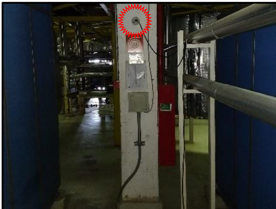
Foto 21 – Transdutor fixo em pilar do mezanino.
