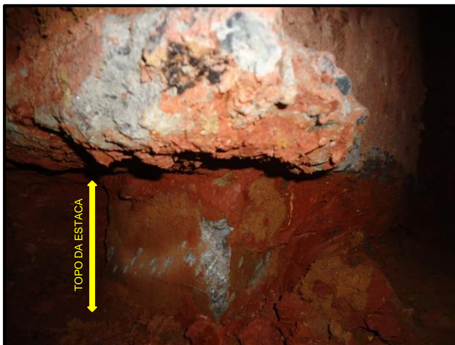
Foto 11 – Vista do topo da estaca e face inferior do bloco.
