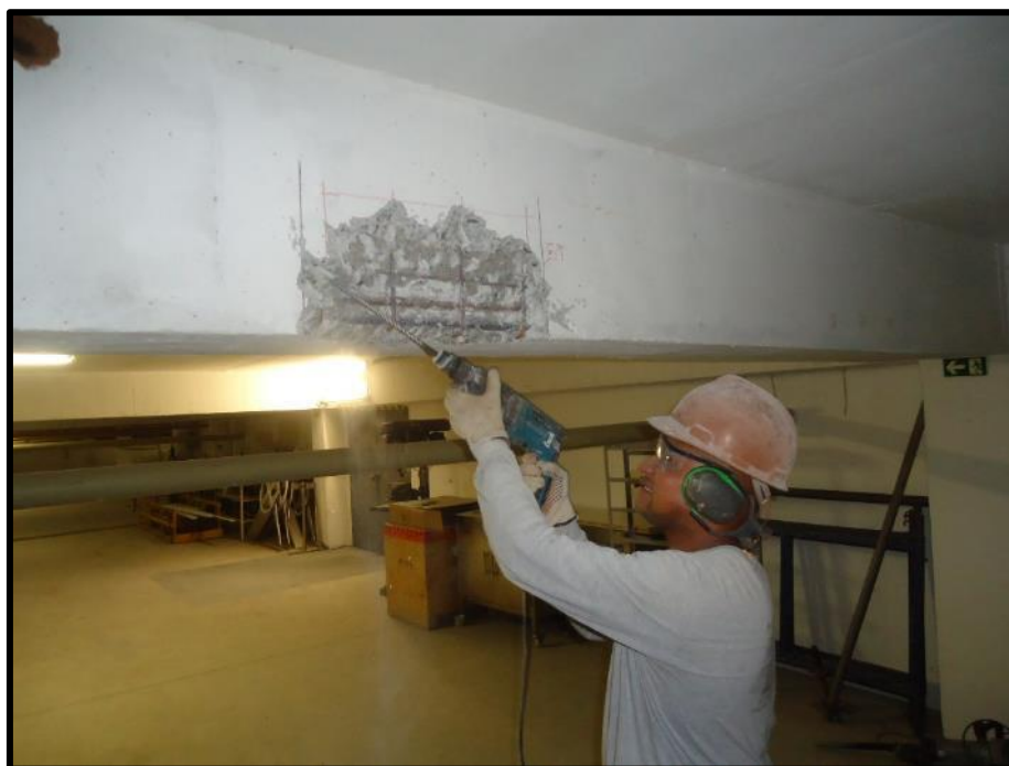
Foto 8 – Prospeção destrutiva em viga para identificação dos diâmetros, quantidade e disposição de armaduras.
