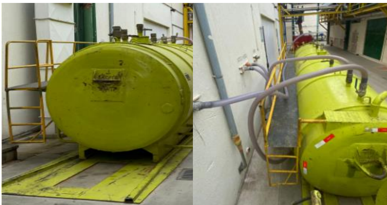
Figura 4: Visão geral do tanque tipo rollon acoplado em sistema de descarte por sucção.
