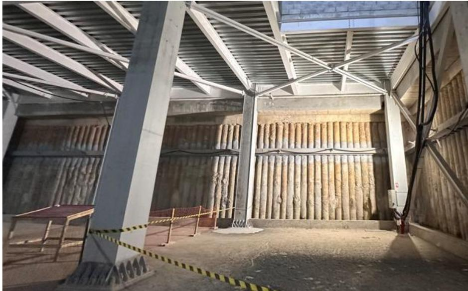
Imagem da Contenção em Estacas Secantes do CPS Butantan
