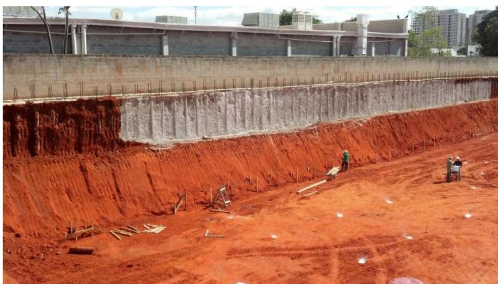
Imagem da Obra "The Diplomat", apresentada pela H2OBRAS em diligência e que demonstra a contenção de solo com estacas espaçadas
